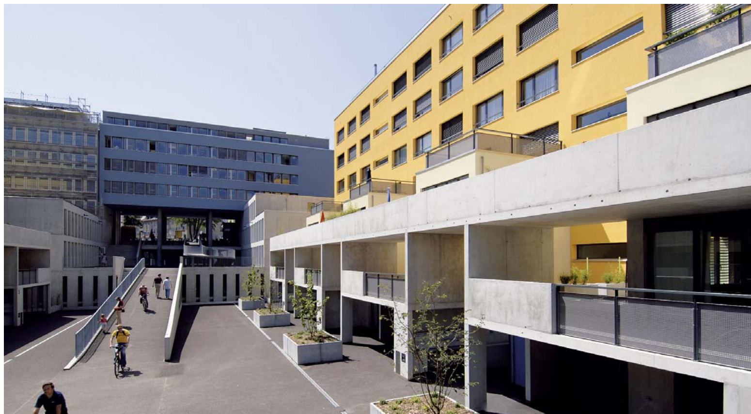
Die Ueberbauung Scheuerrain in Bern, ein Projekt von reinhardpartner.
